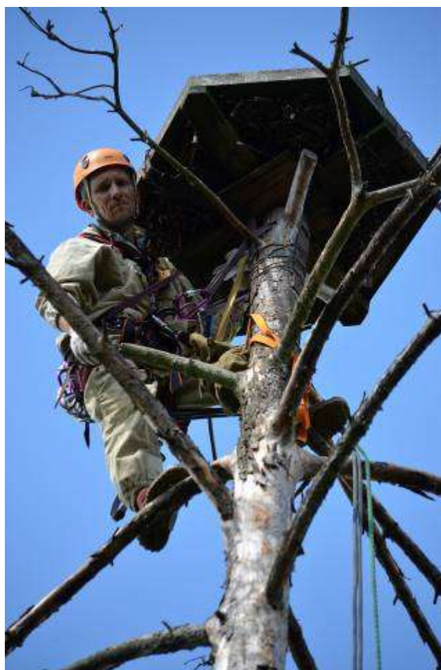
Рисунок 8.6.15-16. Волонтёр И.Фарафонов во время ремонтных работ на гнезде скопы, Лопатинский мох, 08.08.2018 г. Фото И.Фарафонов, М.В.Сиденко.
